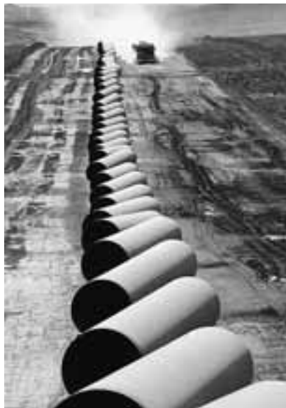
DE BTC OLIEPIJPLEIDING (BAKOE-TLIBIS-CEYHAN), 2005
