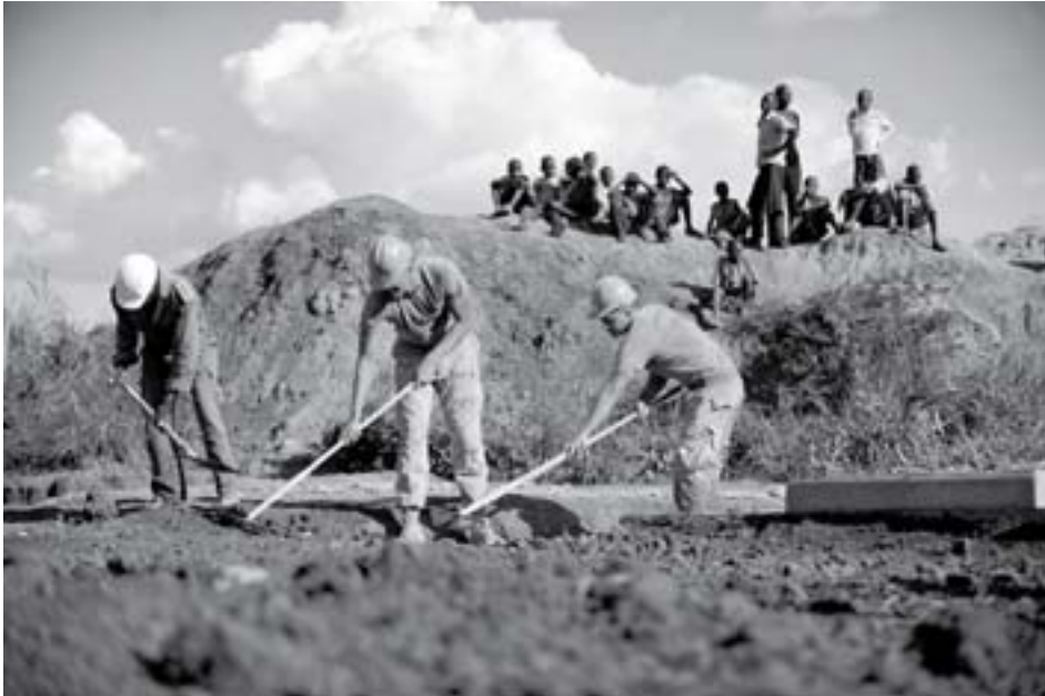
Onder leiding van ingenieurs van de VS-marine wordt gewerkt aan een strategische brug in Oeganda. Foto Sgt Dawn Price
